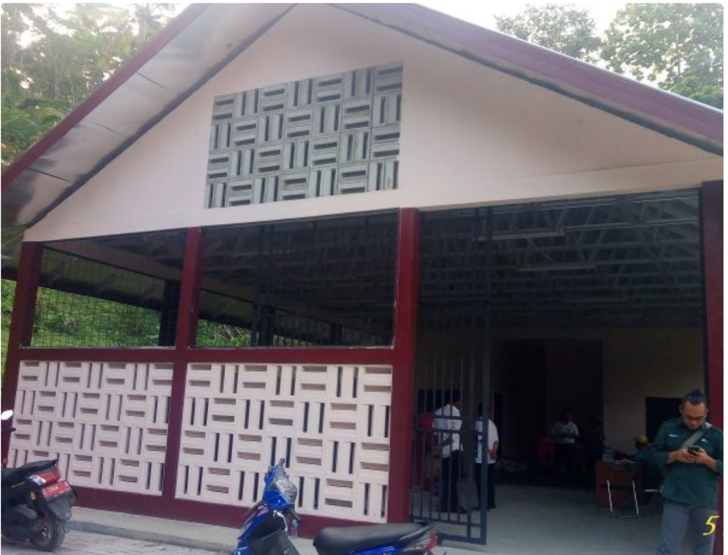
Bangunan Lokasi TPS3R di Dusun Bengkekan Desa Sukahurip Kecamatan Pangandaran. (Photo oleh : MISG/nang surya)
